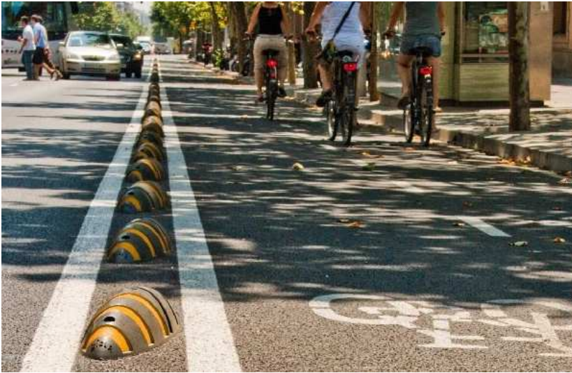
Bild: Eine Radspur mit Armadillos gesichert (Quelle: 1)
